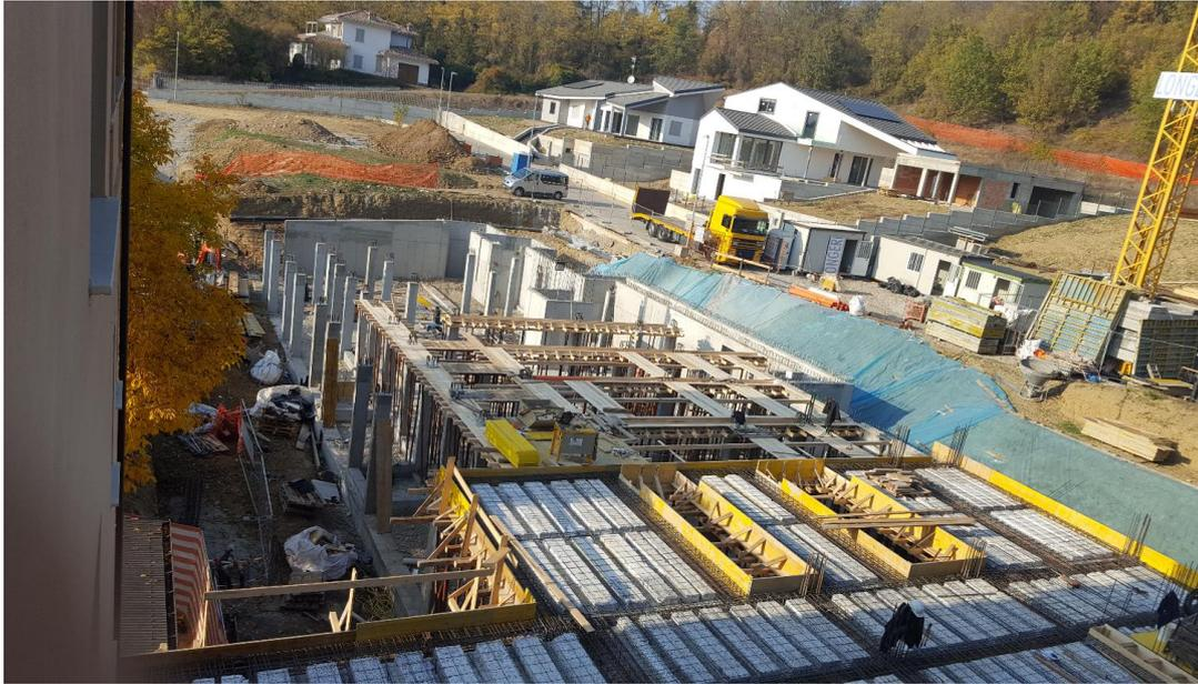
**FOTO 1 - PREDISPOSIZIONE SOLETTA IN CEMENTO ARMATO SU CUI INSISTERA' LA PARTE DI STRUTTURA IN X-LAM (2 PIANI)**
