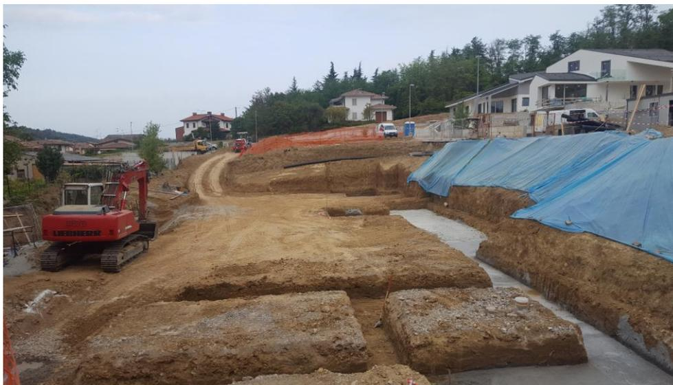
**FOTO 7 – LAVORI SBANCAMENTO TERRENO E PREDISPOSIZIONE SCAVI PER FONDAZIONI**
