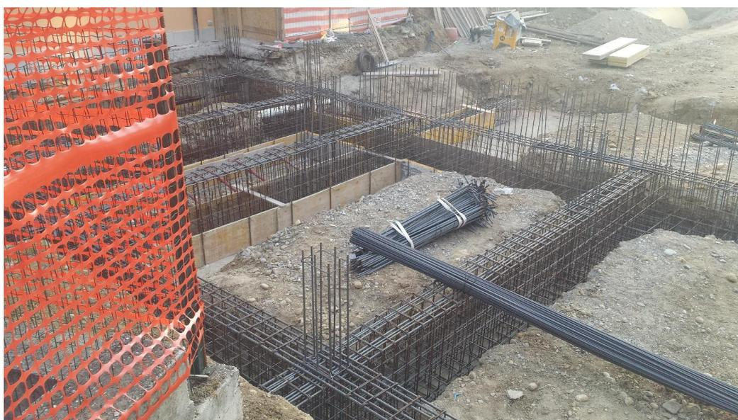
**FOTO 8 – LAVORI DI CARPENTERIA, STRUTTURA METALLICA PER FONDAZIONI IN C.A.**
